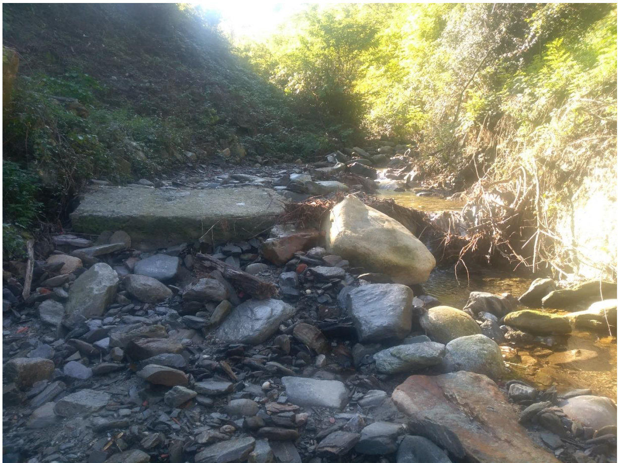
Foto 1 - soglia sez. 1 da ripristinare/completare - vista da valle
