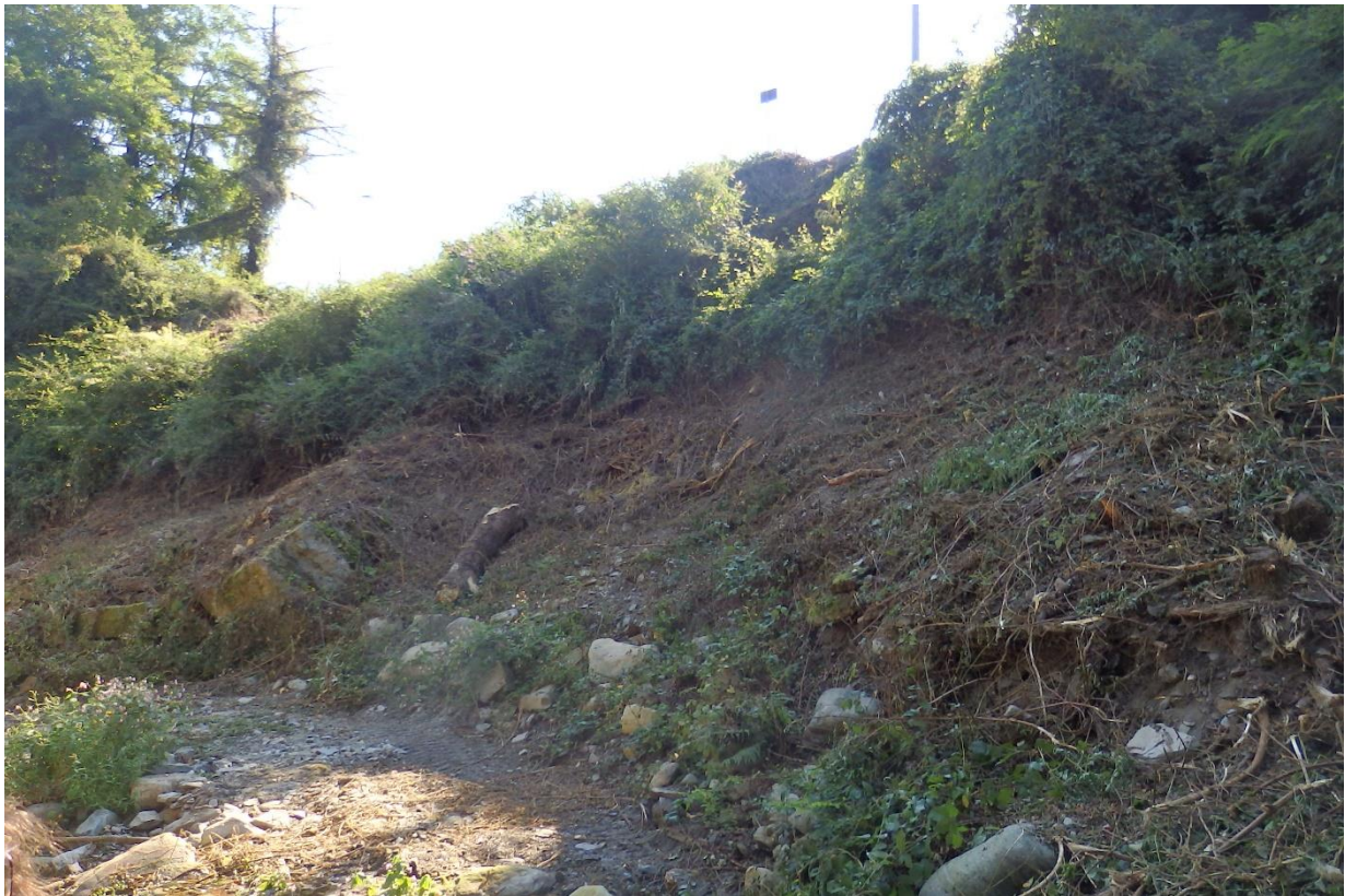
Foto 2 - versante in sponda destra (sez. 1-4) in erosione - vista da monte
